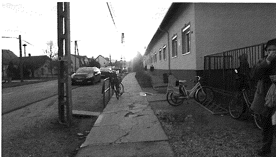
15. számú kép – 6207 j. út mellett vezetett járda
