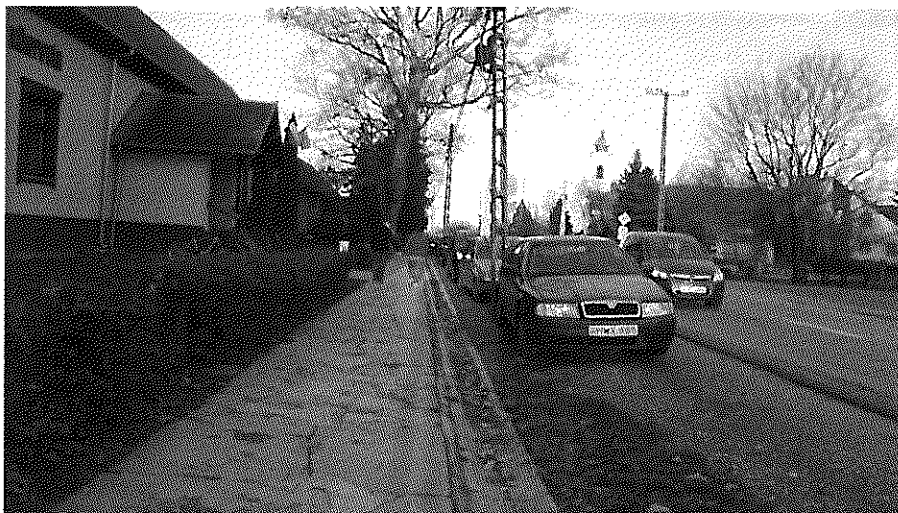
16. számú kép - 6207. j. út mellett vezetett járda
